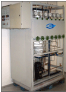
Тепловой насос ТНCO 2 -20 тепловой мощностью 20 кВт, работающий на диоксиде углерода (CO 2 , R744) для установки отопления и горячего водоснабжения (ГВС) индивидуального дома.
